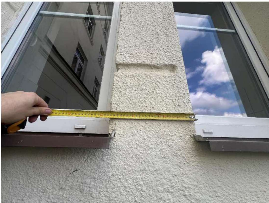
12 pav. Atstumas tarp antrojo ir trečiojo lango – 27 cm
