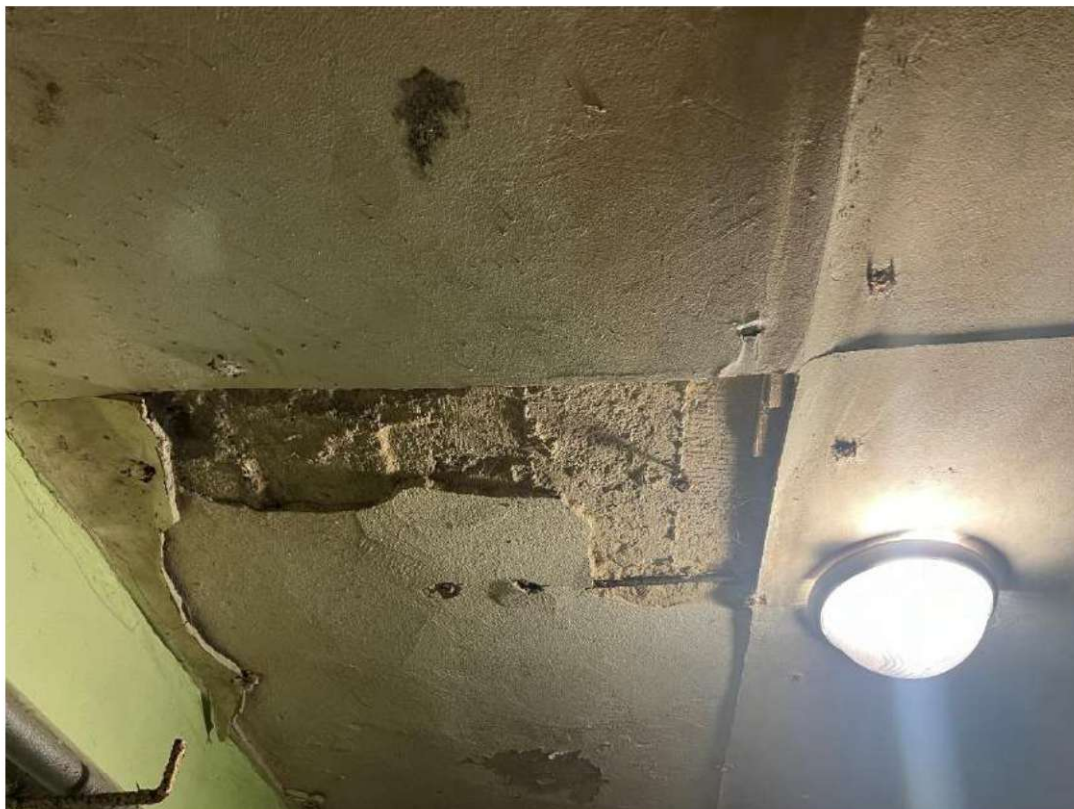
4 pav. Tarp rūsio ir pirmojo aukšto sumontuotos perdangos plokštės fotofiksacija
