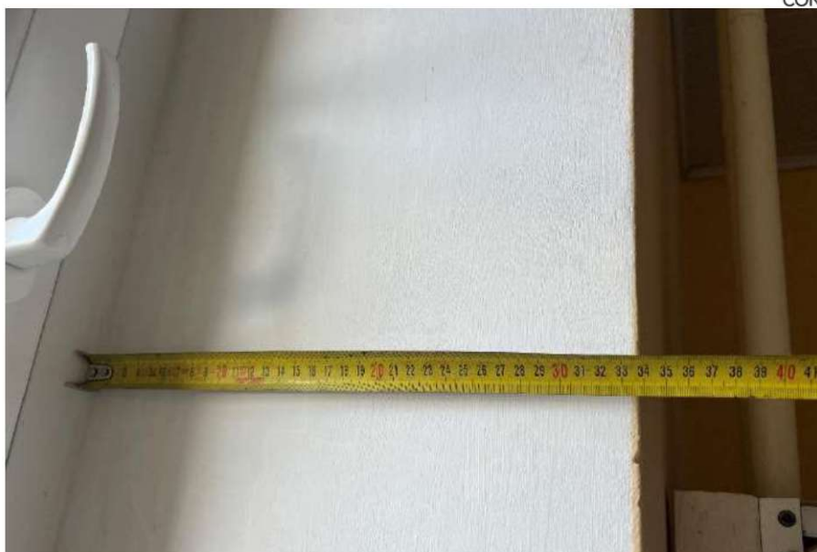
18 pav. Sienos storis pastato viduje iki lango rėmo – 34 cm
