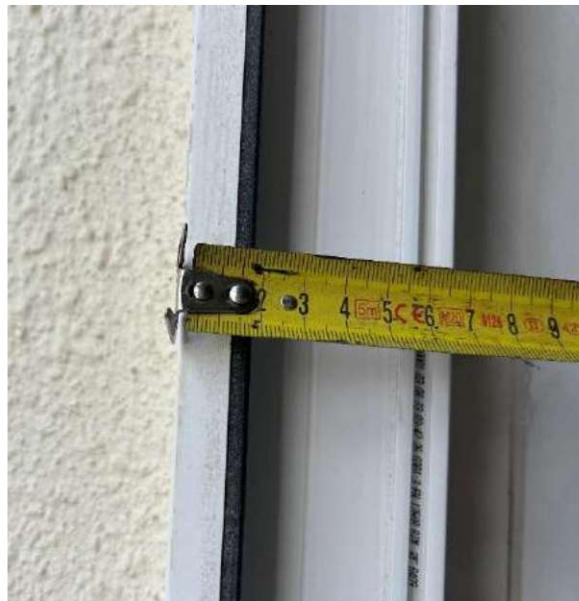
18 pav. Lango rėmo plotis – 6,5-7 cm
