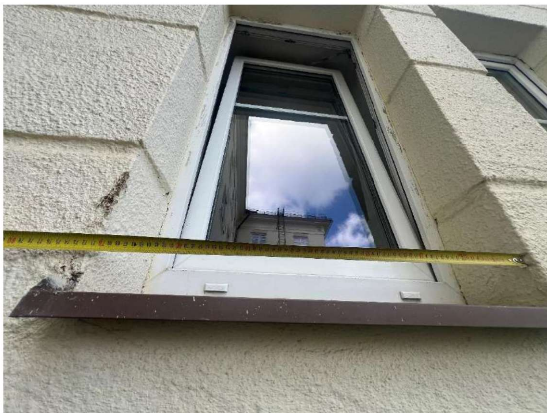
10 pav. Pirmojo lango nišos pločio matavimas – 71 cm
